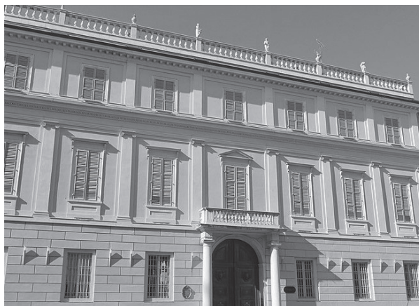
Fig. 1 Palazzo Sanvitale. Facciata (partic.)
